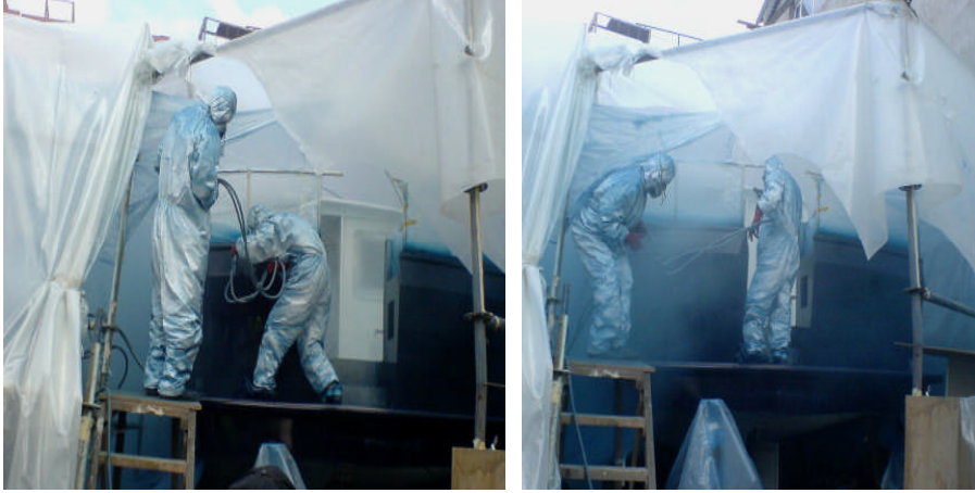
Resim 1.8: Boya, cila, vernik atılması
