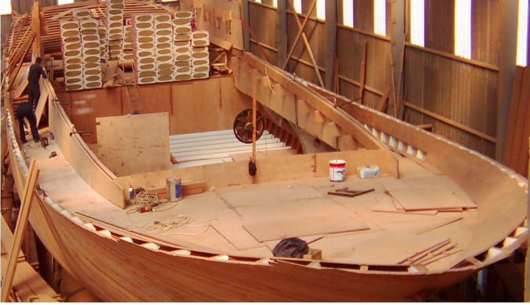
Resim 2.7: Su kontrplağı üzerine izolasyon malzemelerinin serilmesi
