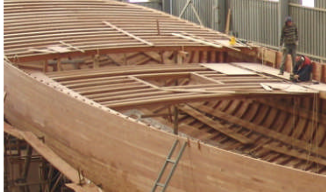
Resim 2.5: Su kontrplağı yerleştirilirken bir kenardan diğer yöne sıra takip edilmesi
